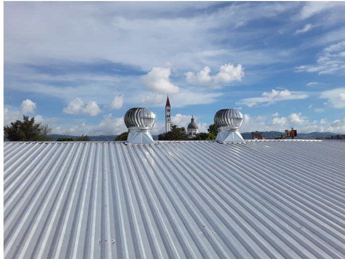
Instalación en cumbrera
